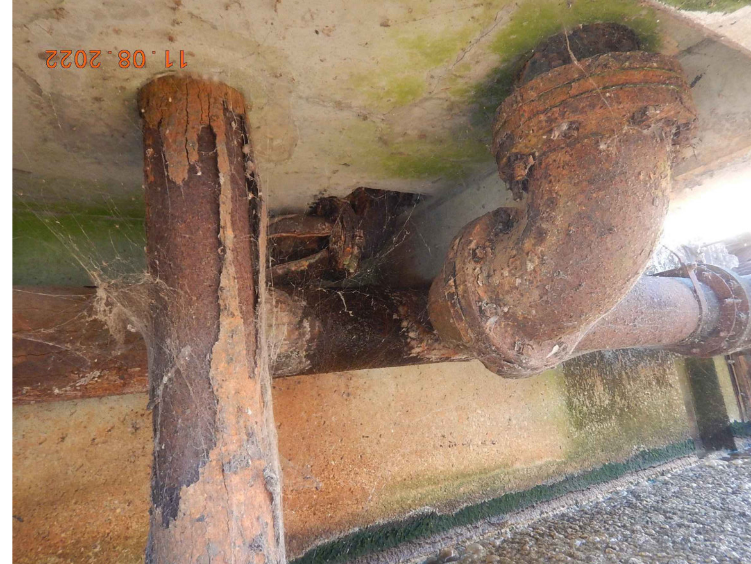
PHOTO No. 2 - EXISTING DI RAS PIPING BELOW SPLITTER BOXES N.T.S.
